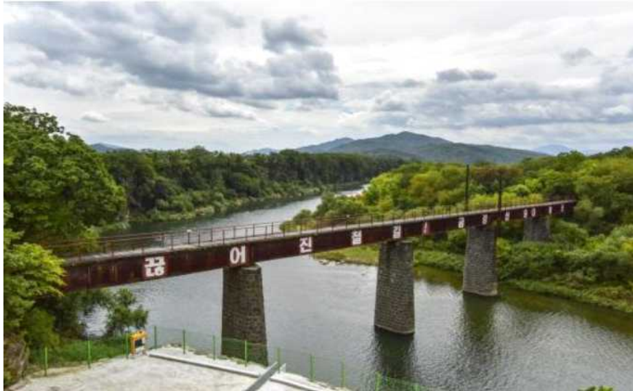
그림 3. 금강산 전기철도 교량(근현대사아카이브)
