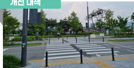
금강보행교 남측 입구 인근 신호등 및 횡단보도 추가 설치
